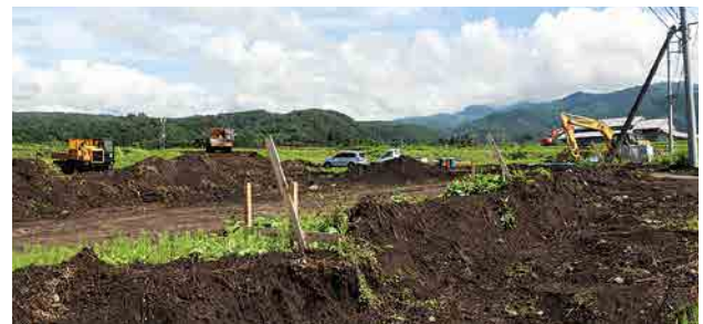
新拠点構想推進事業 造成工事始まる
