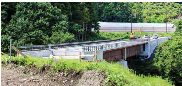
姥堂大橋（仮称）の現在
