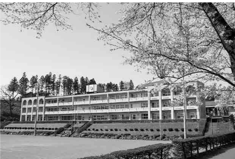
川場中学校 校舎
