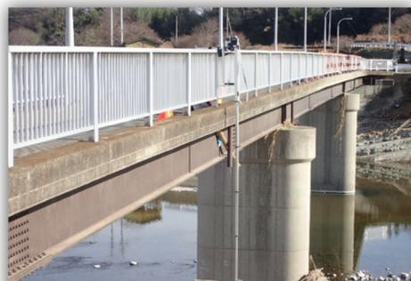
ロボットカメラによる点検状況
