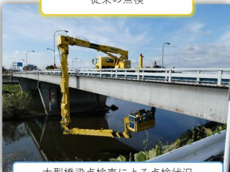
大型橋梁点検車による点検状況
